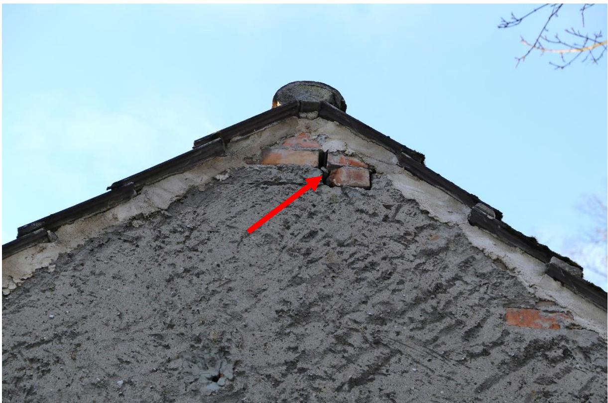
Abbildung 8: Offene Spalten im Mauerwerk bieten ggf. gebäudegebundenen Tierarten potenzielle Einschlußmöglichkeiten in den unbewohnten Dachboden des Wohnhauses (hier Ostgiebel).
