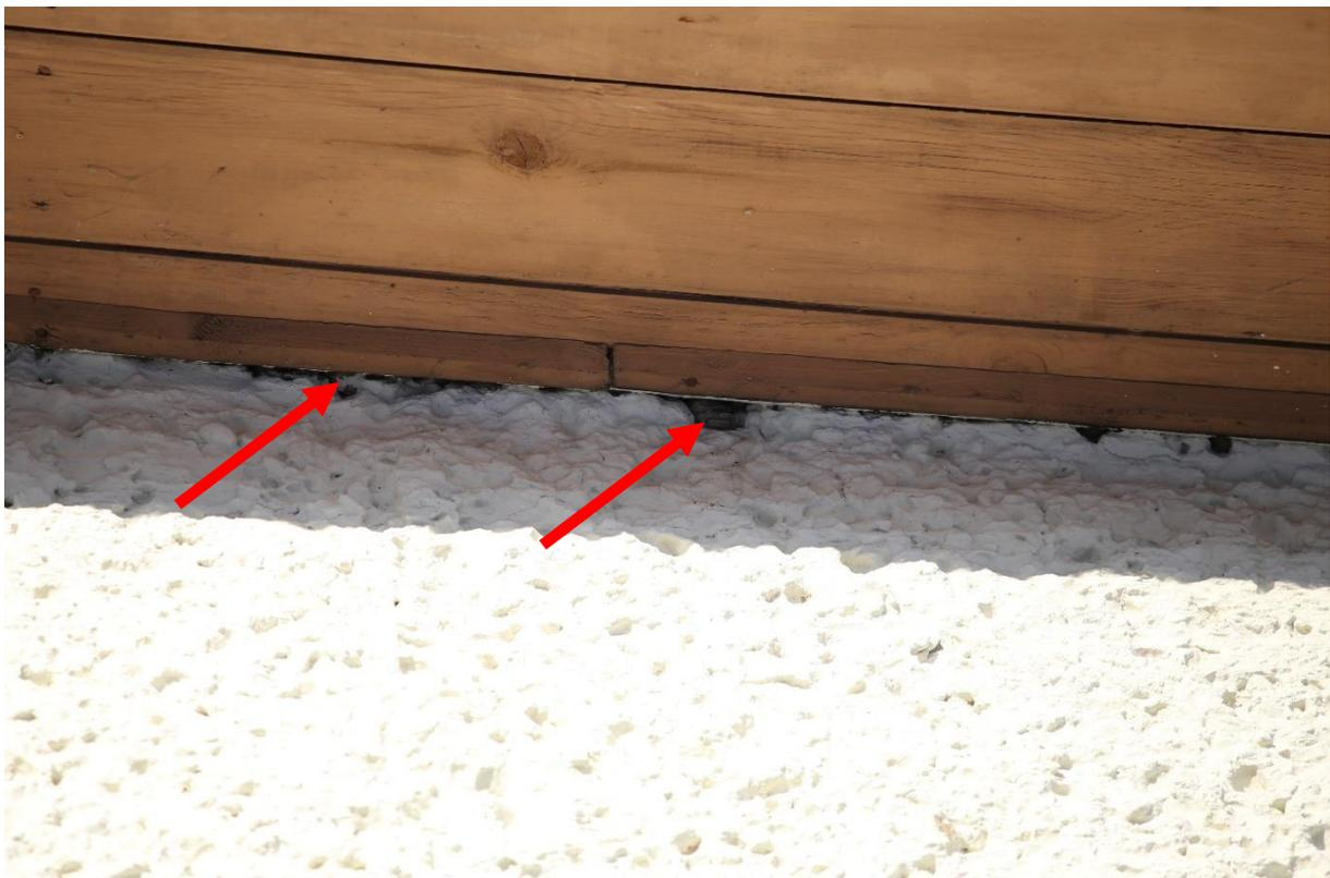
Abbildung 6: Fehlstellen zwischen Dachkasten und Wandputz bietet am Amtsgebäude potenzielle Einschulpmöglichkeiten für Fledermäuse, wie z.B. die gebäudegebundene Zwergfledermaus.
